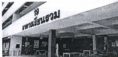
อาคารเรียนรวม ๑๙
